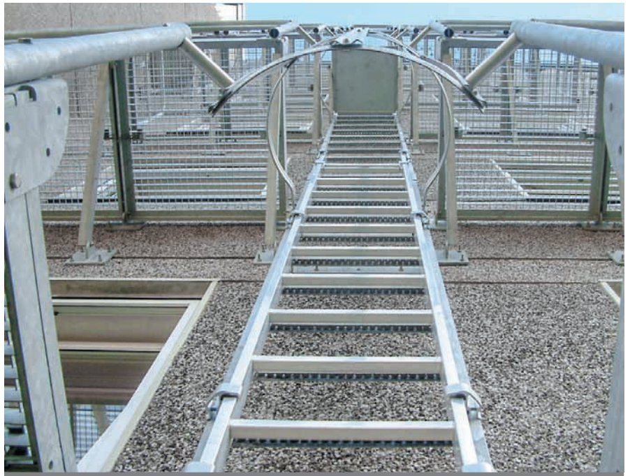
Эвакуационная лестница жилого здания
