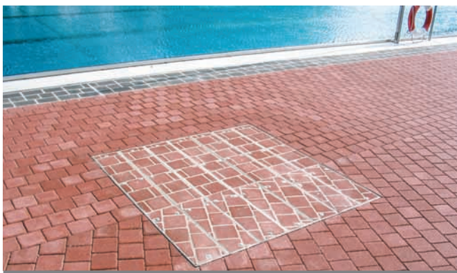
Шахтный люк сегментной конструкции в бассейне
