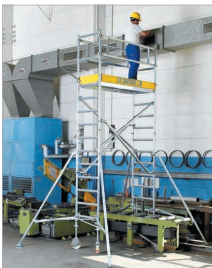
Передвижные вышки без связей могут быть шириной 0,75 м или 1,35 м, а высотой – до 10,40 м. Связи могут отсутствовать до высоты 1,90 м.
