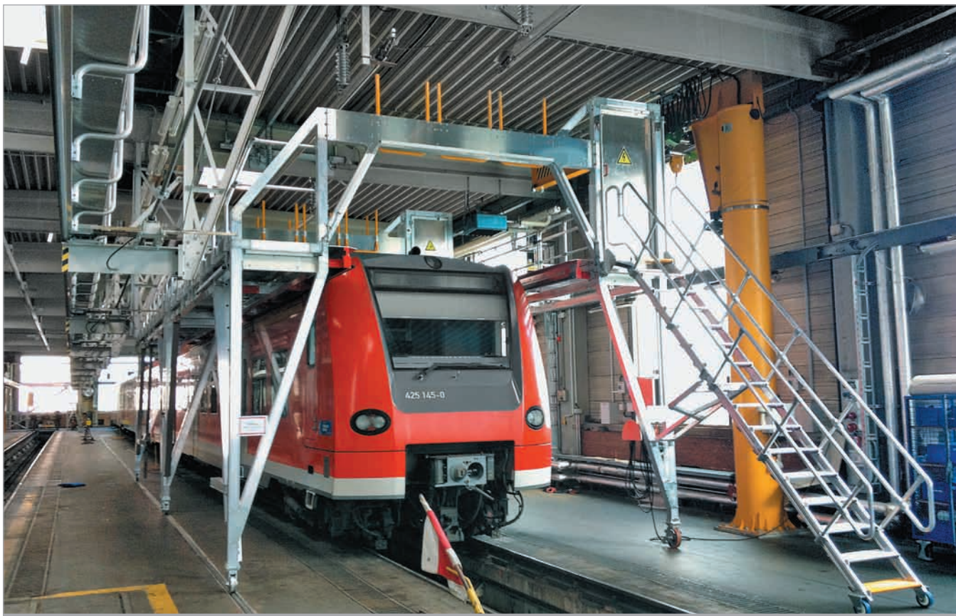
Рельсовая порталная платформа для работ на крыше
