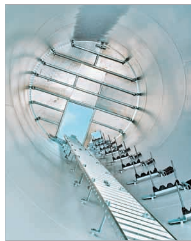
Лестница для подъёма наверх и площадка
