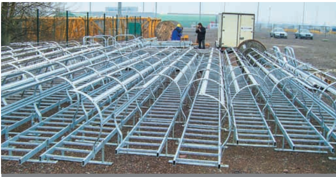
Односекционные настенные лестницы Предварительно собранные лестницы с ограждающим кожухом перед монтажом
