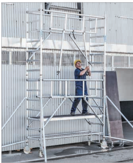
1. Первоочередная установка перил
