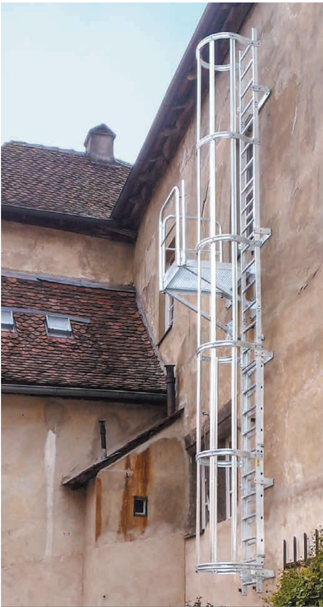
Односекционная лестница с площадкой аварийного выхода
