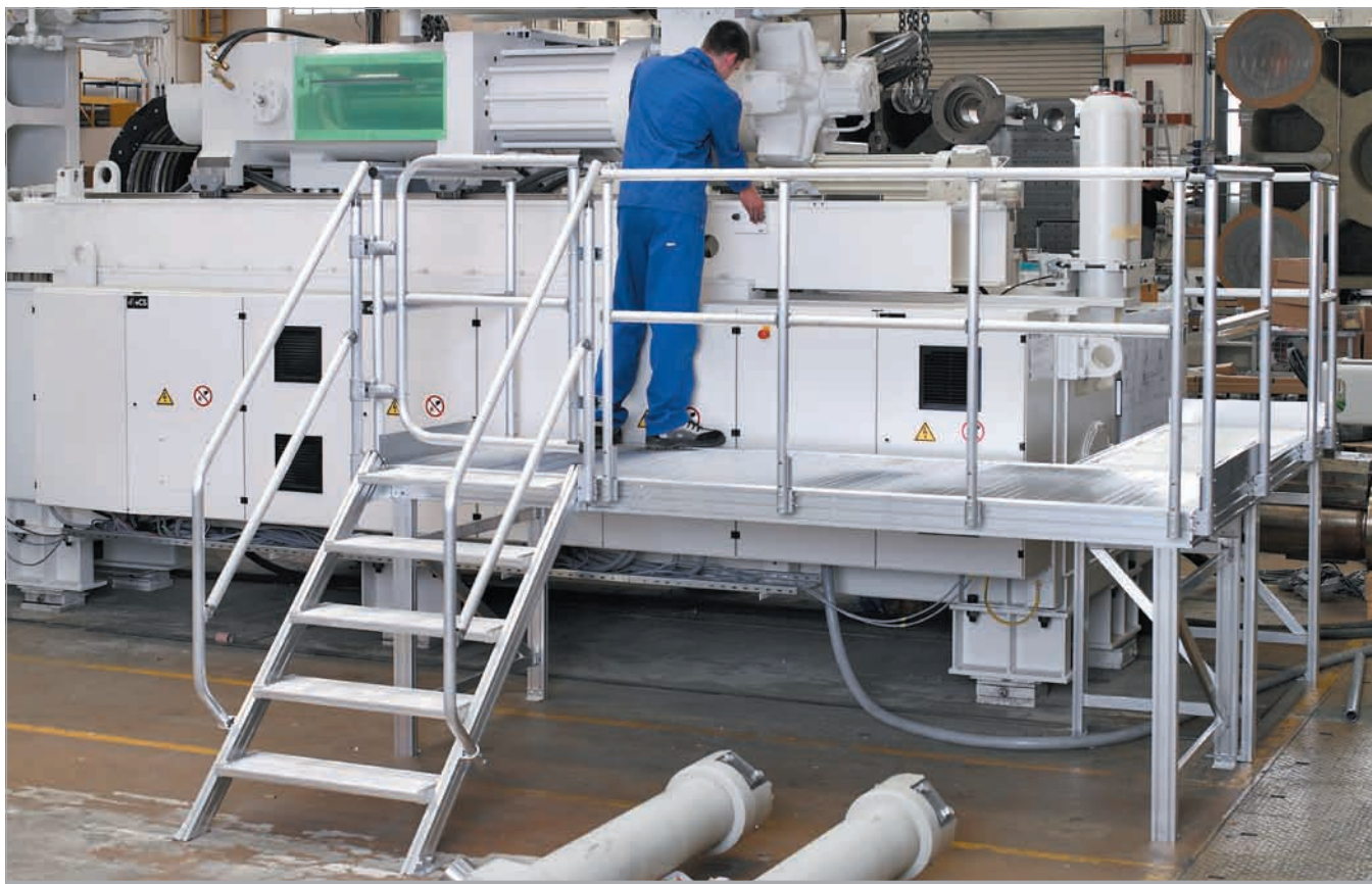
Адаптированная к контурам рабочая подмость с лестничным подъёмом
