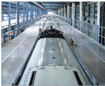
Платформа на уровне крыши длиной 920 м для техобслуживания по ICE
