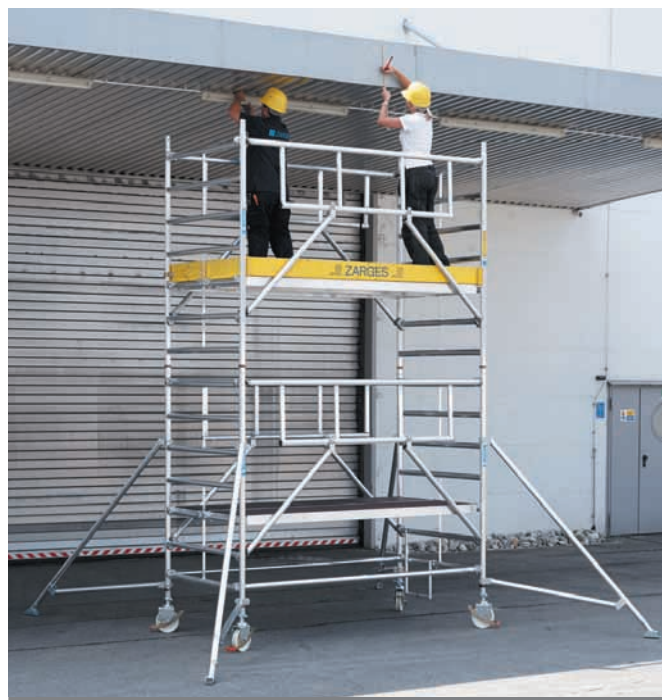
Передвижная вышка Z 600 S-PLUS с консолями и рабочей площадкой двойной ширины (см. на с. 220).
