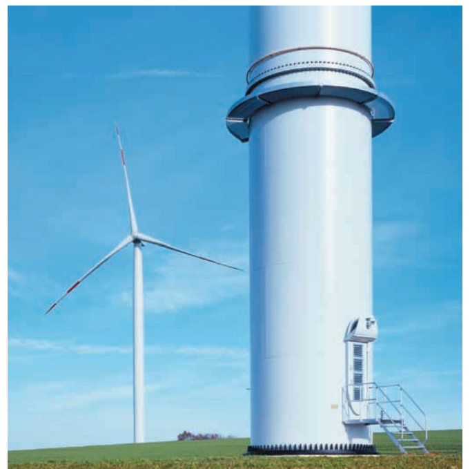
Наружная лестница для ветряной электростанции (см. с. 326)
