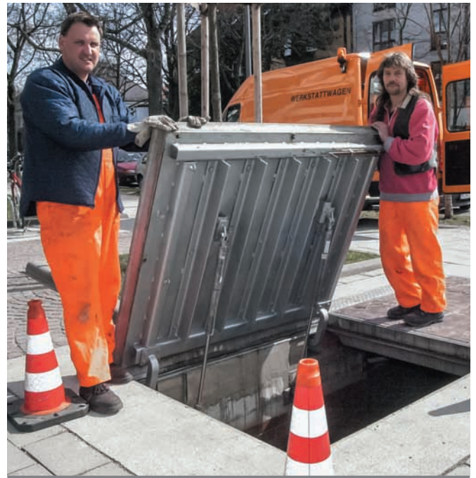
Шахтный люк с газонаполненным амортизатором
