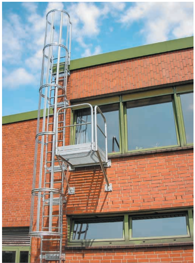
Односекционная эвакуационная лестница с площадкой
