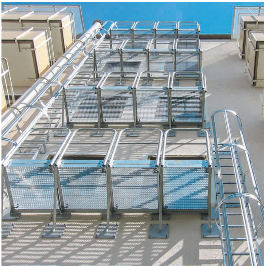
Эвакуационная лестница жилого здания
