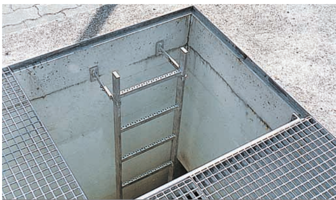
Колодезная лестница из оцинкованной стали
