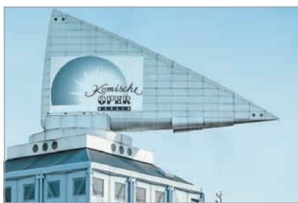
«Парус» с встроенным фасадным подъёмником в Берлине
