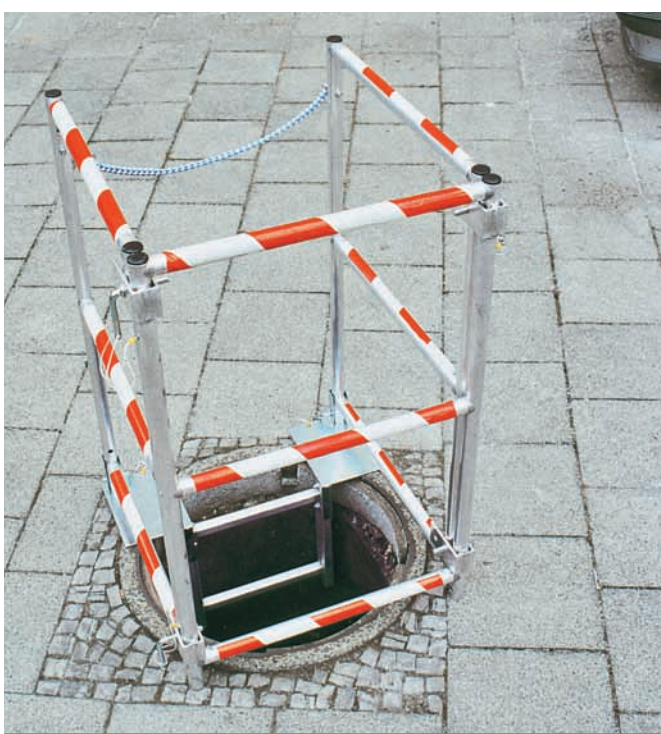
Спуск в открытый колодец на многолюдной улице
